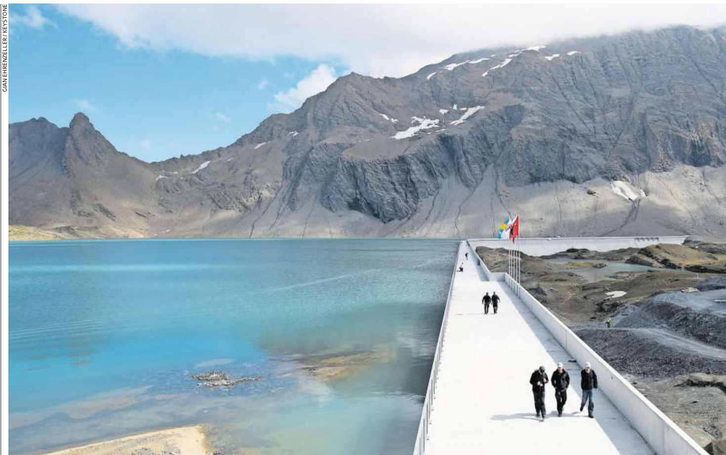
Die längste Staumauer der Schweiz: Pumpspeicherwerk Limmern der Axpo. (Linthal, 9. September 2016)
